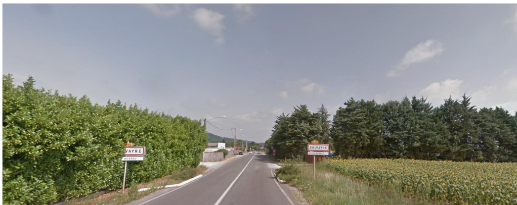
Figure 17 : Entrée de ville Sud
